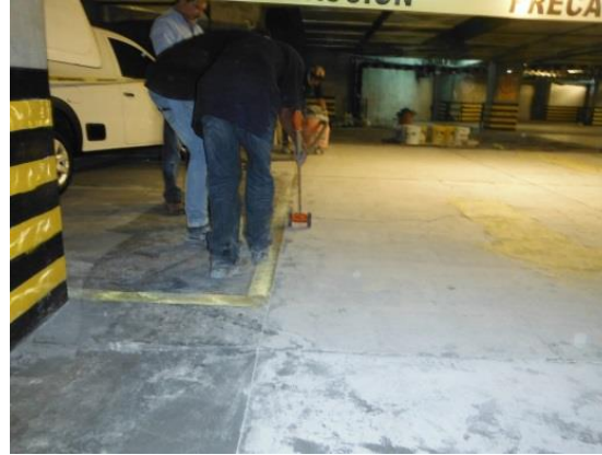
APLICACIÓN DE PINTURA EPOXICA EN TRES NIVELES DEL AREA DE ESTACIONAMIENTO EN EDIFICIO DE OFICINAS
