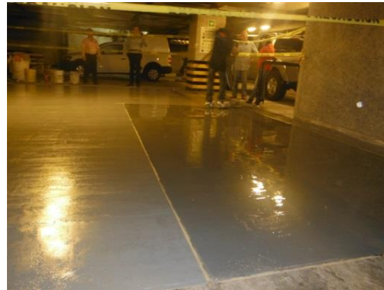
APLICACIÓN DE PINTURA EPOXICA EN TRES NIVELES DEL AREA DE ESTACIONAMIENTO EN EDIFICIO DE OFICINAS
