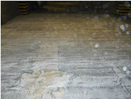
APLICACIÓN DE PINTURA EPOXICA EN TRES NIVELES DEL AREA DE ESTACIONAMIENTO EN EDIFICIO DE OFICINAS
