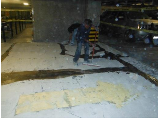
APLICACIÓN DE PINTURA EPOXICA EN TRES NIVELES DEL AREA DE ESTACIONAMIENTO EN EDIFICIO DE OFICINAS
